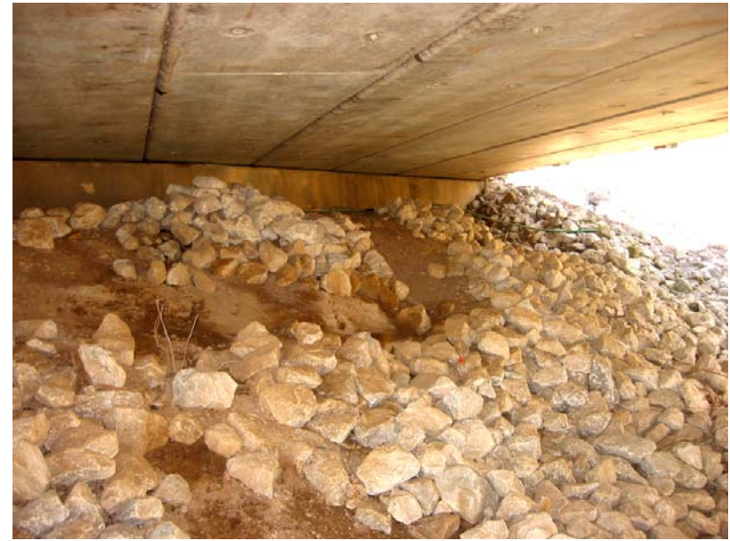
062 Displaced riprap
