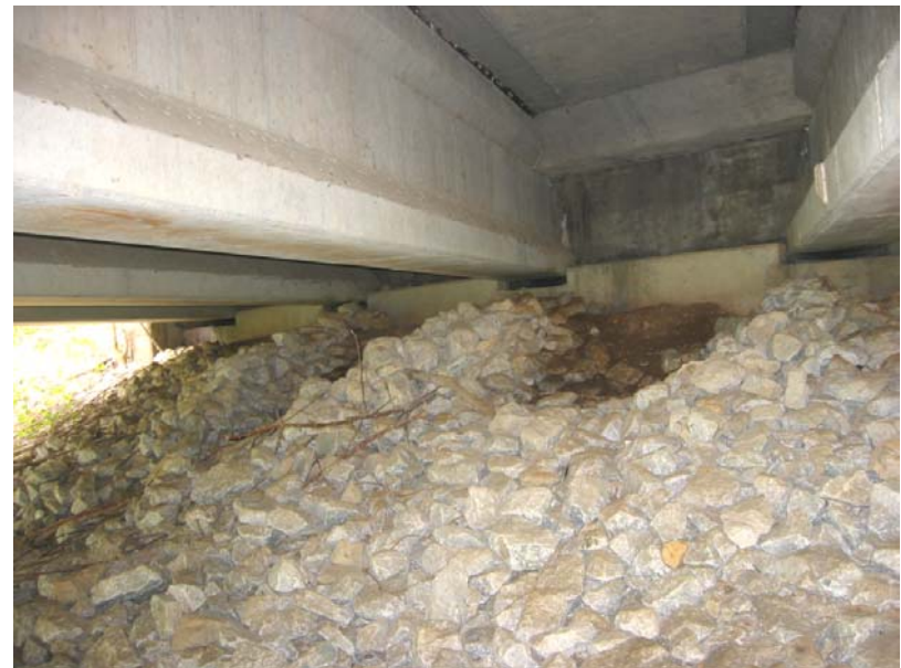
149 Displaced riprap
